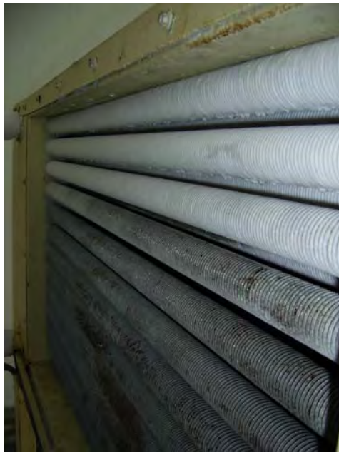
รูปที่3 แผงฮีทเอ็กซ์เชนเจอร์ภายในห้องเย็น(ที่อุณหภูมิภายในห้อง -2 องศาเซลเซียส)
