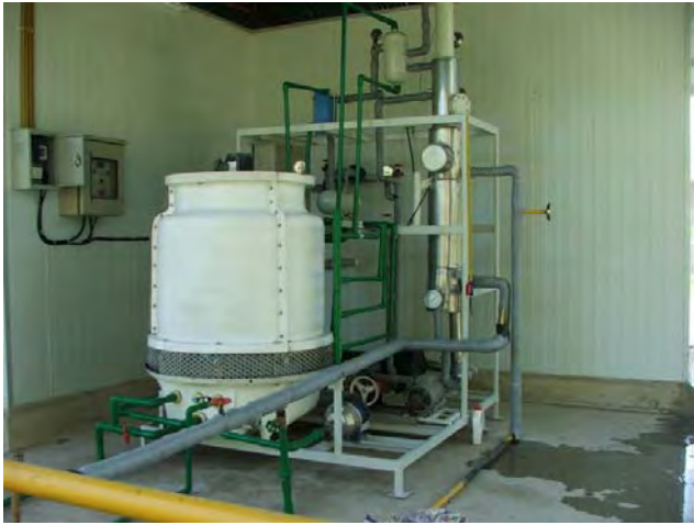
รูปที่2 เครื่องทำความเย็นระบบทำความเย็นแบบดูดซึม
