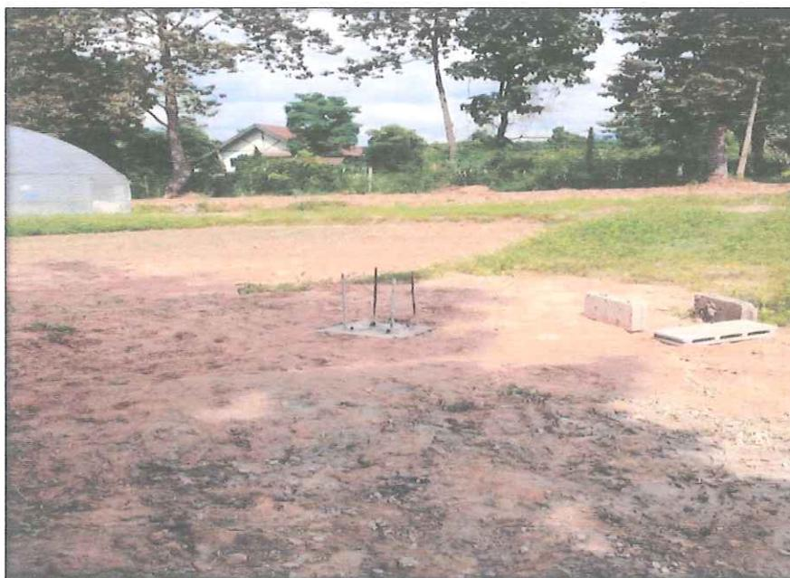
ภาพที่ 18 ฐานยึดเสาไฟสำหรับติดตั้งหลอดไฟ LED
