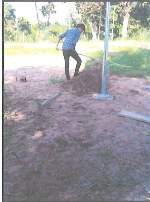
ภาพที่ 23 หลุมนำสายไฟฟ้าจากเสาไฟเข้าสู่ระบบผลิตกระแสไฟฟ้าพลังงานแสงอาทิตย์
